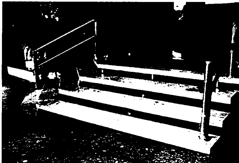
Foto 14: Escada Hotel Serrano Fonte: Autor.
