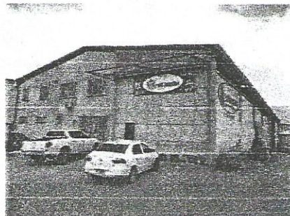
Foto 03- Vista externa de Galpão Industrial
