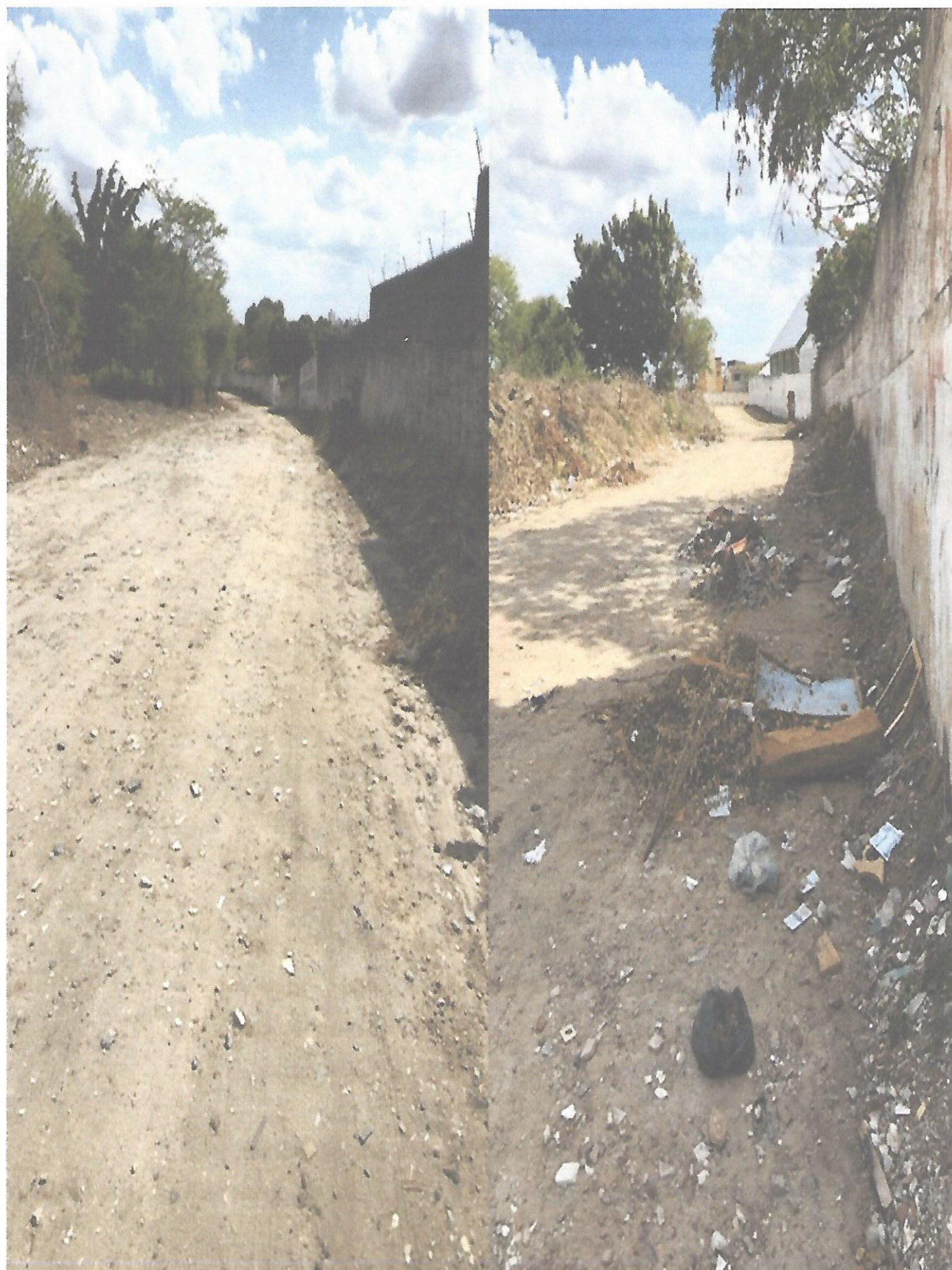
Imagem 1 e 2: a falta de calçamento torna a rua um espaço para o despejo de lixo e demais objetos.
