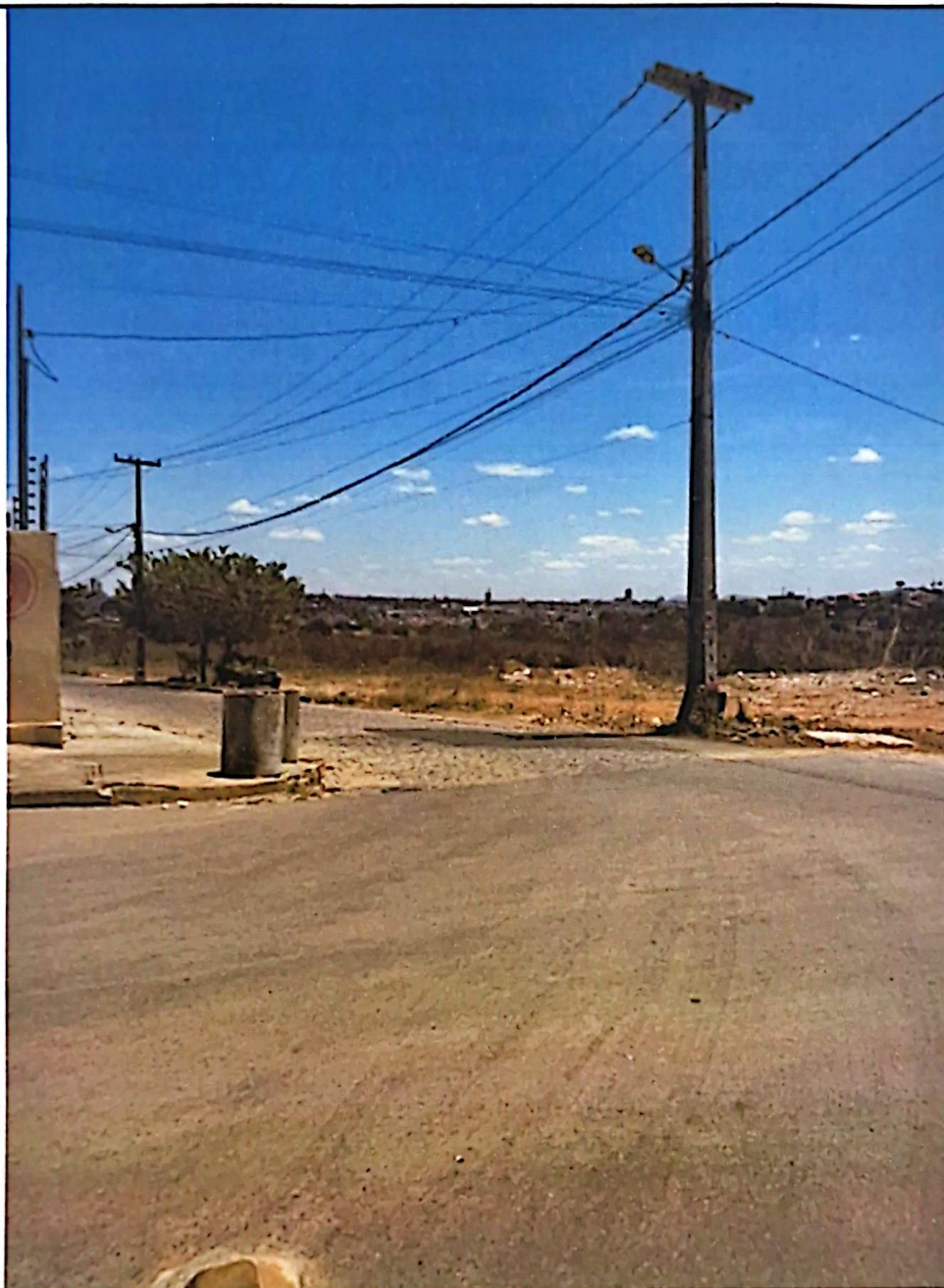
Cruzamento da Rua Maria da Guia Muniz Albuquerque com a Rua Olinda, sem a devida sinalização de trânsito necessária.
