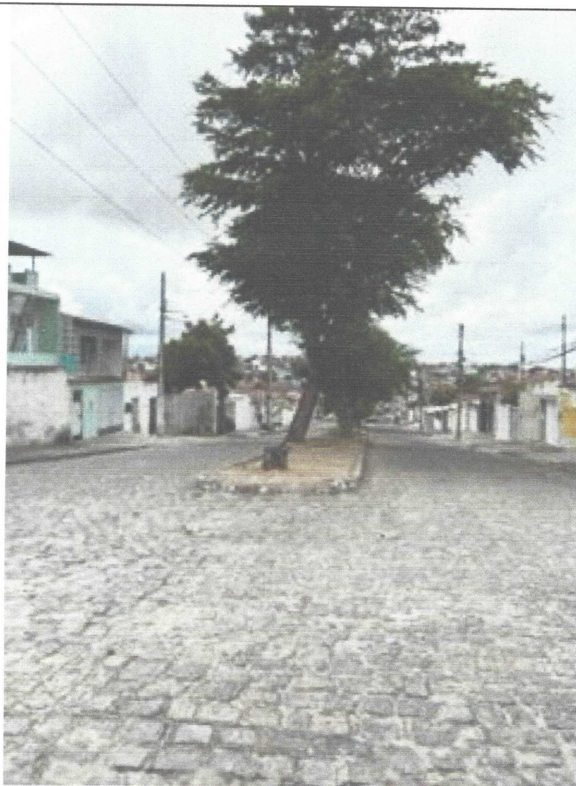
Anexo 1: espaço que necessita de uma requalificação urbanística.
