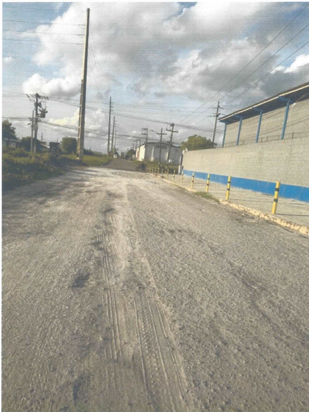
Rua Barão de Mauá (Distrito Industrial) – no cruzamento com a João Wallig. São vários pontos críticos que necessitam de reparos.
